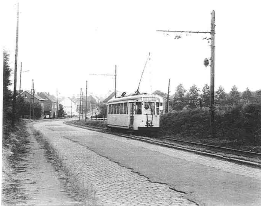
Een oneindige rij schots en scheve bovenleidingsmasten met die vreemde dubbele rijdraad langs de slecht opgelapte kasseiweg. (Lenniksebaan, Gooik, richting Brussel)
